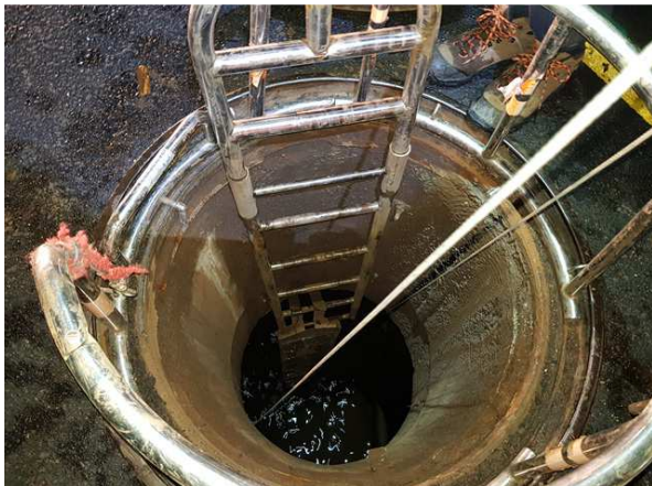
내용 수직구 상태양호 상태양호
