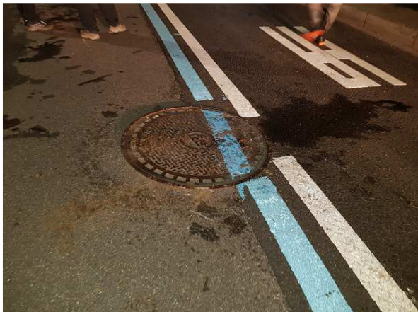
내용 포장부 아스콘망상균열 보수
